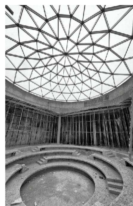
диусом 16 метров. Возможно, это самый большой стеклянный купол структурной конструкции в России. Внутри фитостена высотой 5 метров и длиной 17 метров с системой автополива
