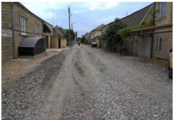
Ремонт 710-метрового участка дороги находится на активной стадии. В настоящее время рабочие завершают устройство основания из песчано-гравийной смеси, формируя дорожное корыто для последующей укладки асфальта. Производится тщательное уплотнение грунта,
